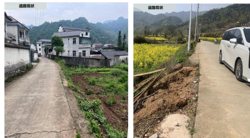
南坑组道路现状
