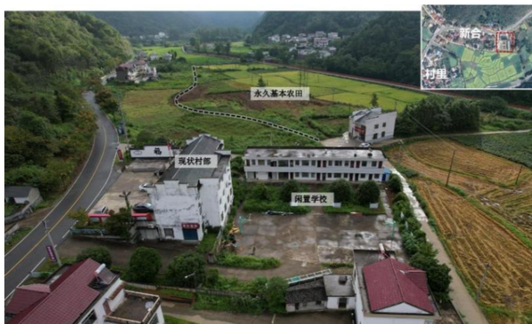
图 5-2 核心建设区现状航拍
